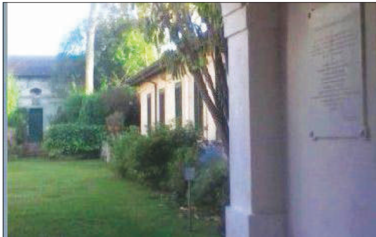
Polistena (RC) - Palazzo Valensise. Edificato nel 1797 sulle rovine del cinquecentesco convento dei Padri Domenicani di Polistena, crollato con il terremoto del 1783
